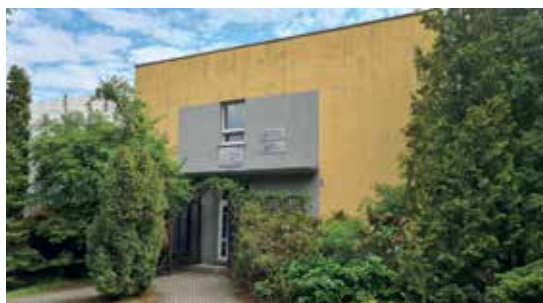
Budynek CBRA w Poznaniu.
