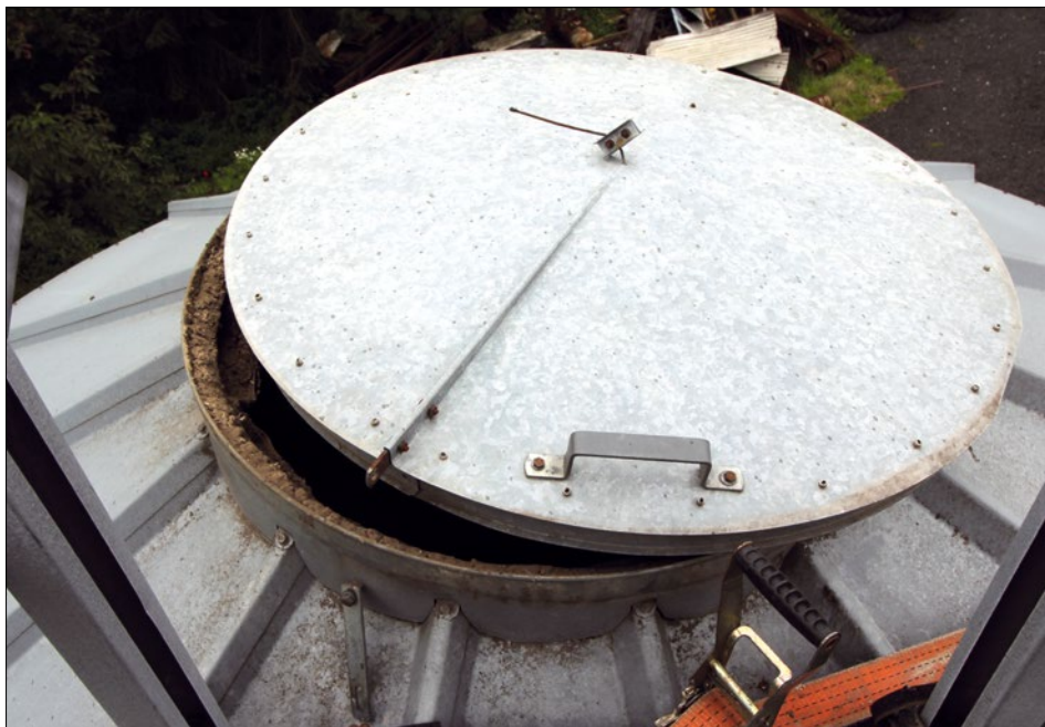
Fot. 4.7. Właz na szczycie silosu zbożowego (fot. T. Klejdysz)
