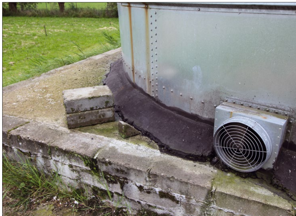
Fot. 4.5. Wlot powietrza u podstawy silosu umożliwiający swobodne wnikanie owadów – szkodników magazynowych do wnętrza obiektu (fot. T. Klejdzysz)
