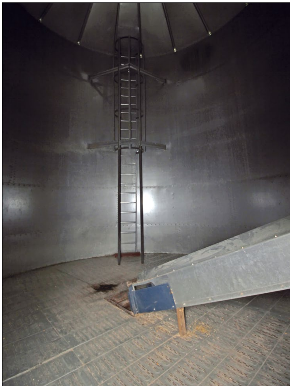
Fot. 4.6. Wnętrze silosu zaopatrzone w drabinę (fot. T. Klejdysz)
